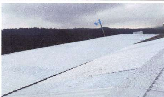
Foto 1: Cambio de Techo por Lamina Troquela Aluzinc Calibre 26 Modulo Primaria y Parvulos
