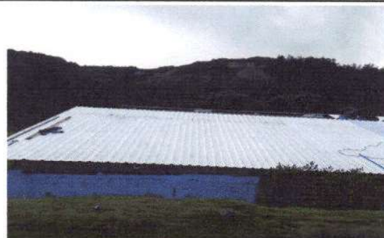
Foto 2: Cambio de Techo por Lamina Troquelada Aluzinc Calibre 26 Modulo Cocina y Primaria
