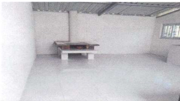
Foto 3: Sustitucion de Piso Ceramico en Cocina
