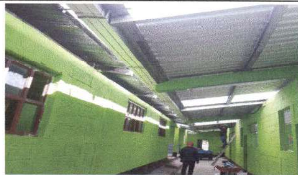
Foto 4: Sustitucion del Sistema Electrico Modulo Primaria
